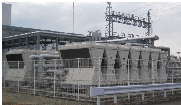
ヒートポンプ式冷熱源設備(持田製薬工場(株)本社工場)
